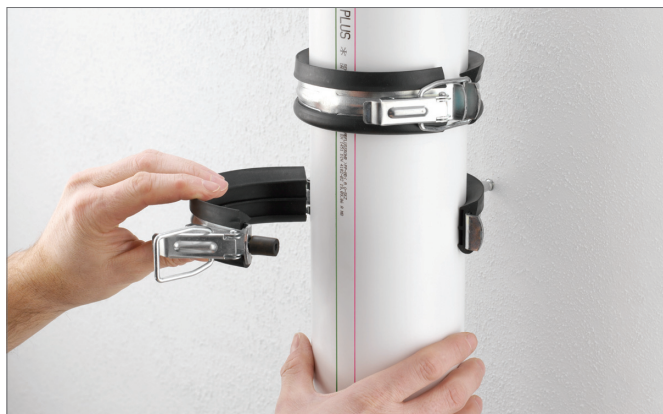
Рис. 7-2 Установка трубы
