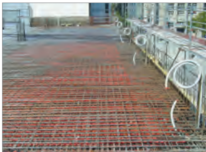
Рис. 8-2 Участок бетонирования ВКТ
