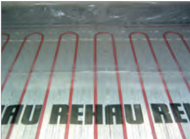
Рис. 3-59 Система укладки труб на теплоизоляционных матах TS-14
