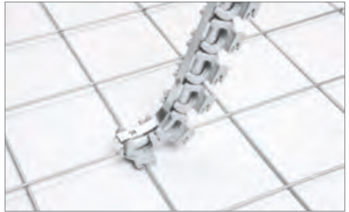
Рис. 3-49 Установить штангу с магазином поворотных клипс
