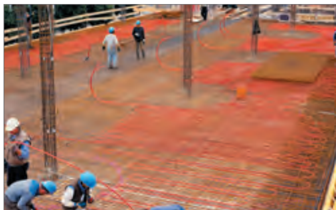
Рис. 8-5 Модули ВКТ REHAU, укладываемые на месте
