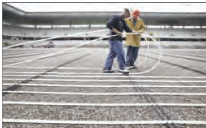
Рис. 9-34 Укладка отопительных труб
