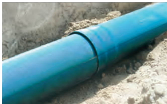
Рис. 9-33 Укладка дренажа на игровом поле
