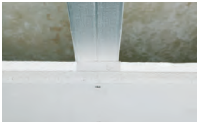
Рис. 4-6 Крепление потолочных панелей
