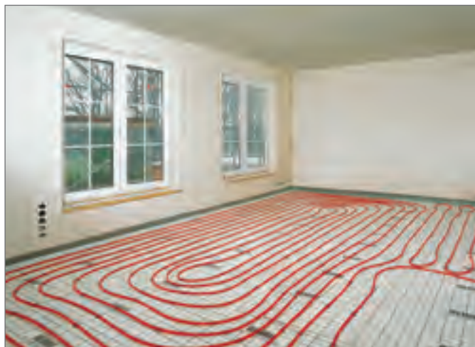
Рис. 3-22 Система крепления труб с помощью гарпун-скоб
