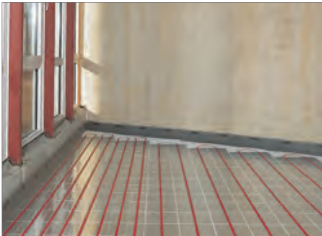
Рис. 3-49 «Сухая» система укладки труб
