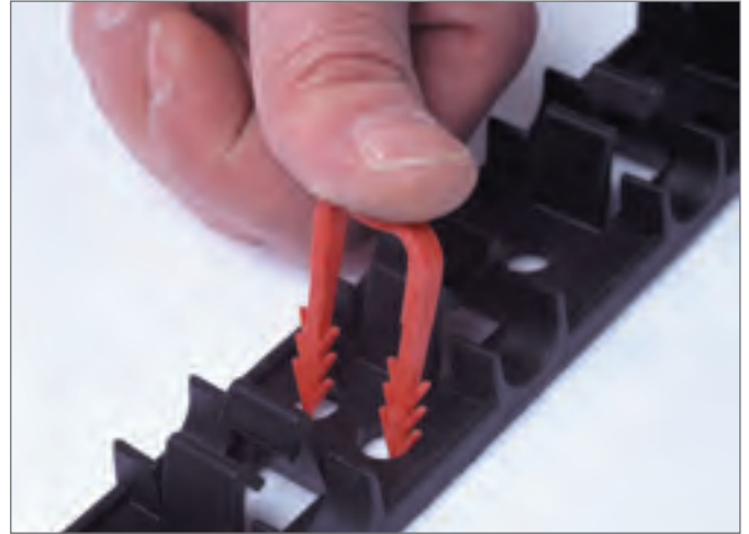
Рис. 3-35 Вдавливание гарпун-скоб в конструкцию пола
