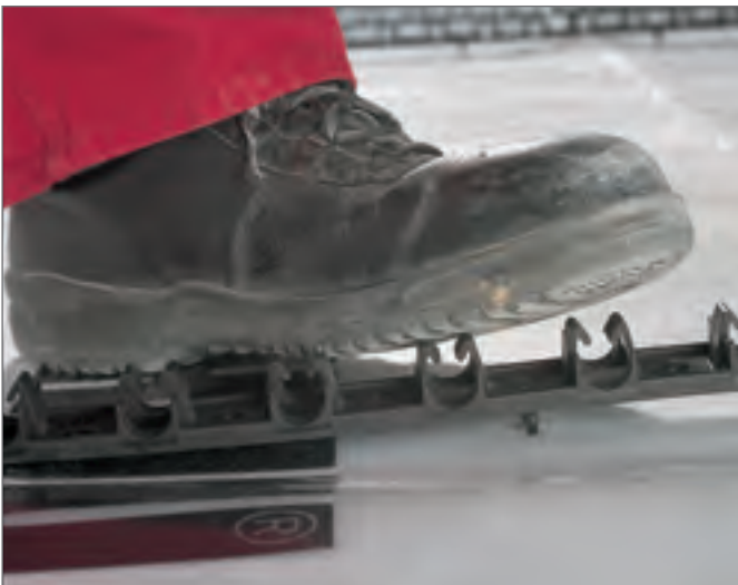
Рис. 3-34 Вдавливание фиксирующих шин RAUFIX в конструкцию пола
