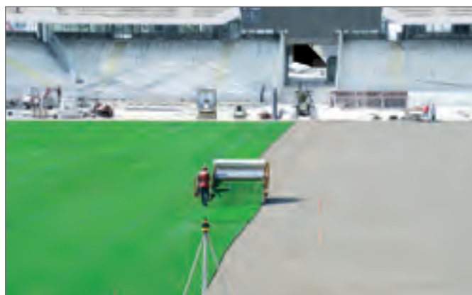
Рис. 9-35 Укладка газона
